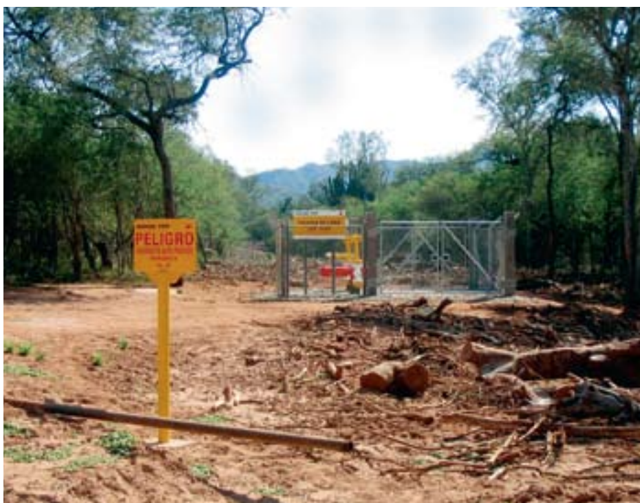
HOUTKAP TEN BEHOEVE VAN PIJPLEIDINGEN
