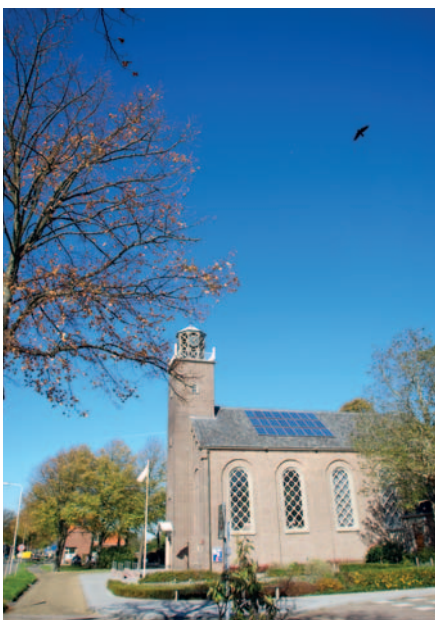
▲ De Protestantse kerk in Schoondijke met de panelen op het dak.
